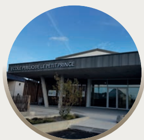
Restaurant scolaire Groupe scolaire 150 510 €
